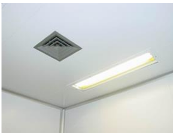
Figura 1.2 - Saída da tubulação de um sistema de ar condicionado central
